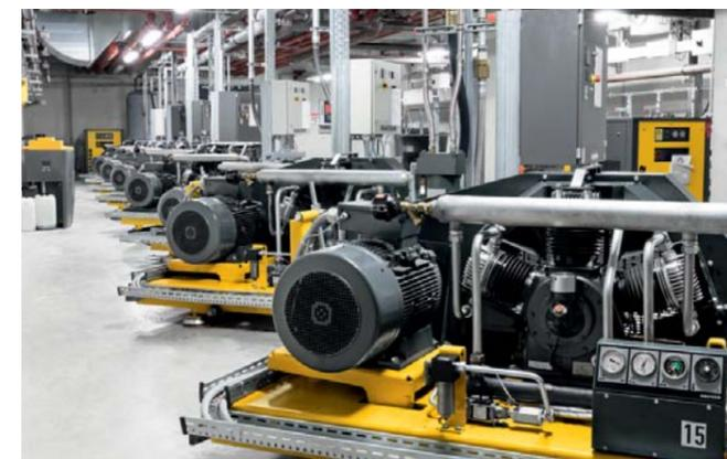
Foto de arriba: estación de compresión de 10 bar con compresores de tornillo.
