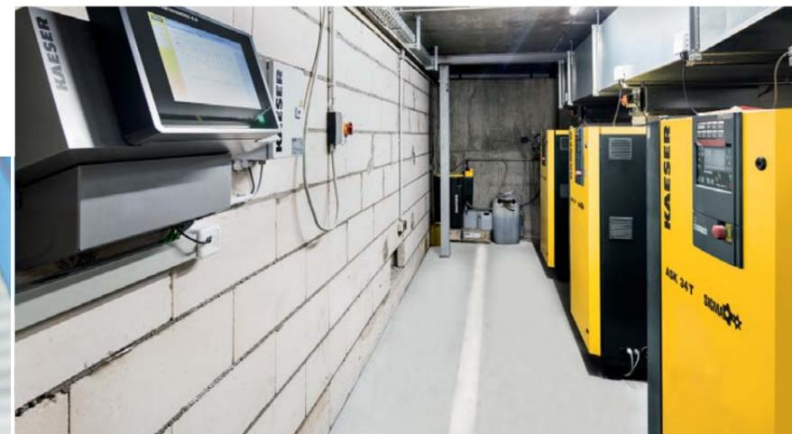
La ultramoderna estación de compresores es supervisada por un controlador maestro SIGMA AIR MANAGER 4.0.
