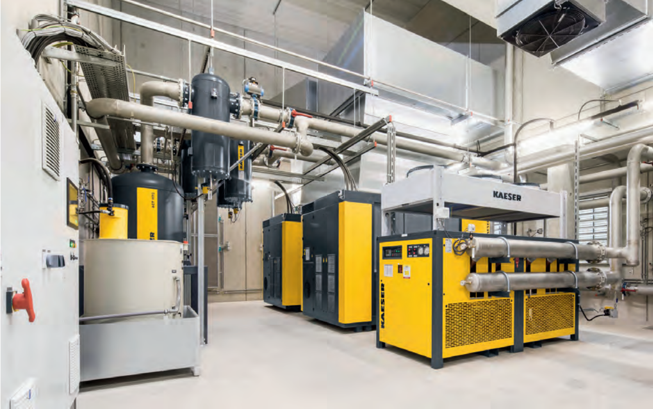
Los secadores refrigerativos modelo TL 1301 y ABT 25, los absorbedores de carbón activado, los microfiltros finos a modo de prefiltros y los posfiltros para alcanzar la clase de partículas 1 (conforme a ISO 8573-1), junto con varios dispositivos más de filtrado, garantizan la alta calidad del aire comprimido.
