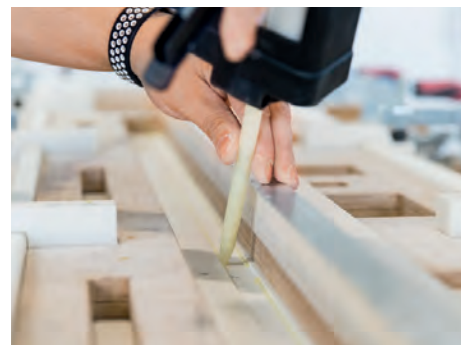
Aplicación de adhesivo multicomponente.
