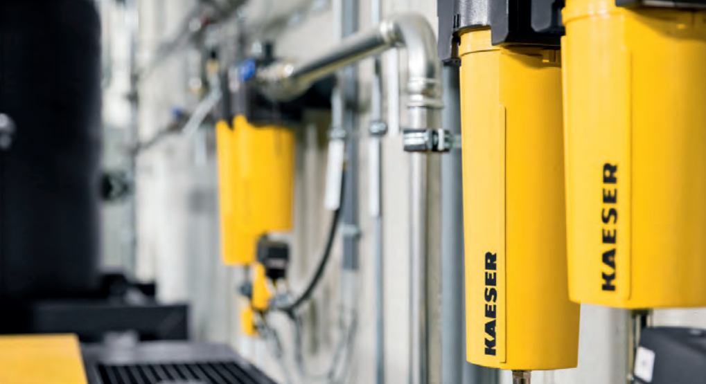
Los secadores refrigerativos modelo TL 1301 y ABT 25, los absorbedores de carbón activado, los microfiltros finos a modo de prefiltros y los posfiltros para alcanzar la clase de partículas 1 (conforme a ISO 8573-1), junto con varios dispositivos más de filtrado, garantizan la alta calidad del aire comprimido.
