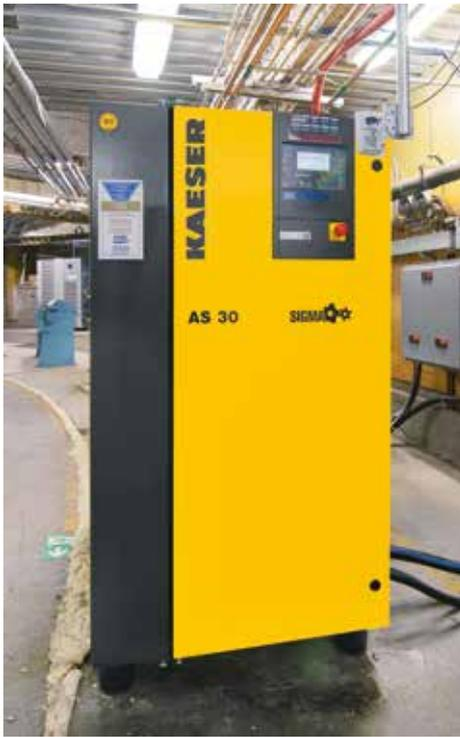
**El compresor de tornillo AS 30 de KAESER debe cumplir requisitos específicos para poder operar a 4300 m de altitud.**
