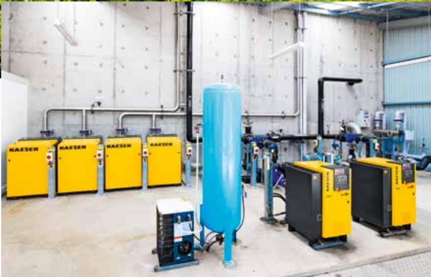
**Cuatro sopladores de lóbulos COMPACT de KAESER suministran el aire de procesos para el biorreactor de membrana.**
