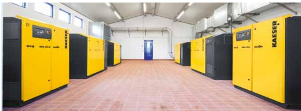
La estación de sopladores de la planta depuradora de Lachen-Speyerdorf con sopladores de tornillo de alto rendimiento de KAESER KOMPRESSOREN
